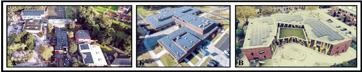
Рис. 5. Використання сонячних батарей у шкільних будівлях Європи та США. А – Приклад встановлення сонячних панелей на даху школи в Англії; Б, В – Реалізація сонячних енергосистем у шкільних комплексах США [9 - 11].
