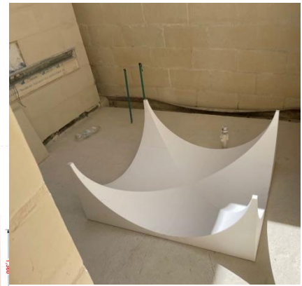
Рис. 5. Виготовлений новий елемент склепінчастої стелі
