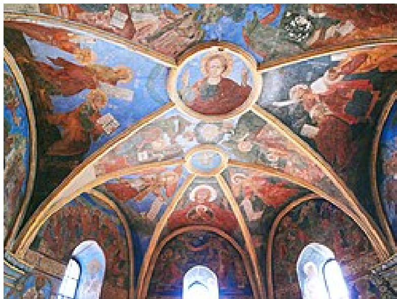
Рис. 6 Нерв'юроподібне склепінчасте перекриття центральної вівтарної апсиди церкви Спаса на Берестовому. Фото з відкритих джерел мережі Інтернет. https://uk.wikipedia.org/wiki/Церква_Спаса_на_Берестові
