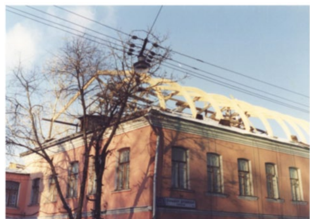
Рис. 12 - Каркас з гнуклєєних рам надбудови мансардного поверху будинку
