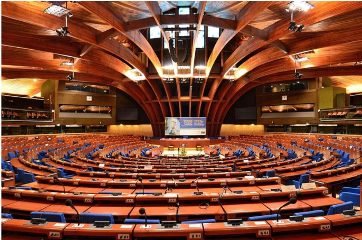
Рис. 13 - Каркас покриття з гнотоклесених рам над залом засідань парламентської Асамблеї ради Європи (Бельгія)
