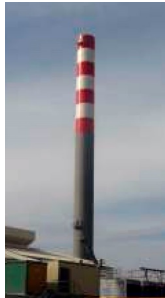
Рис. 6. Нанесення червоних та білих попереджувальних смуг на поверхню труби [16]
