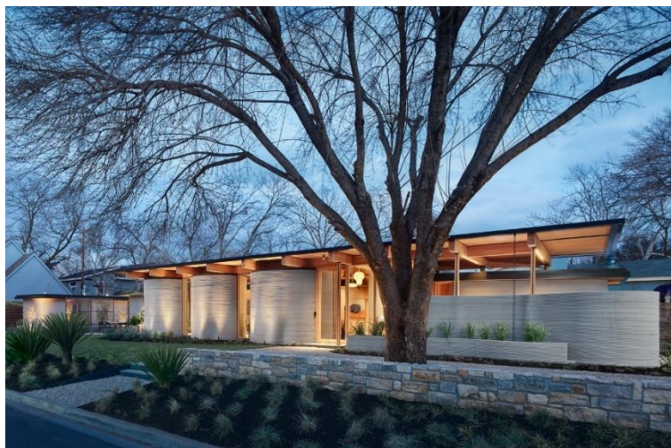
Рис. 5. Житловий будинок «House Zero» в м. Остін, США
