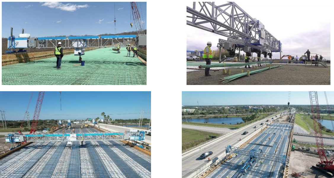
Рис. 2. Будівництво мосту в Порт-Сент-Люсі-Вест-Бульвар у Флориді із застосуванням системи будівельних роботів IronBOT та TuBOT [12]
