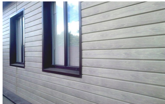
Рис.8. Облицювання металевим сайдингом фасадів будівель
