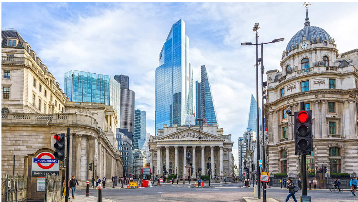
Рис. 3. Вид на офісну будівлю 22 Bishopsgate Tower
