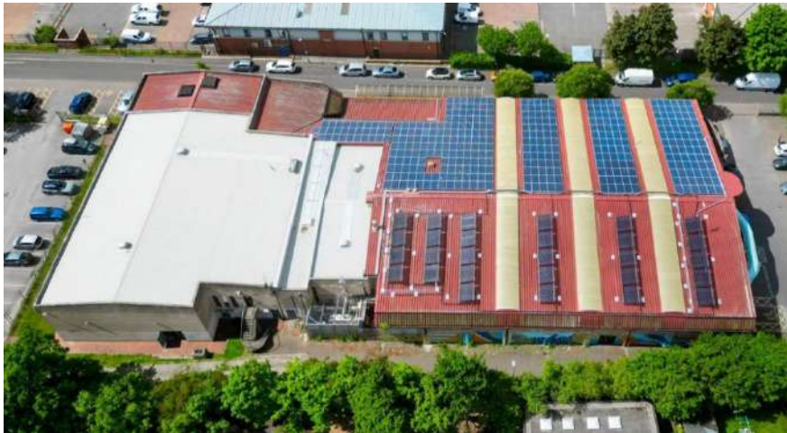
Рис.4. Центр Дозвілля Істон з сонячними панелями та геліоколекторами, що допомагають заощаджувати кошти при нагріві басейн. Джерело: [14].
