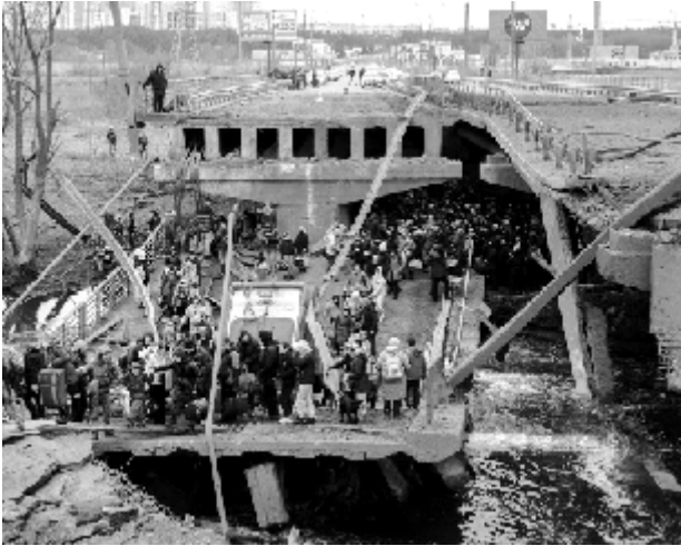
а) Люди переходять зруйнований міст, місто Ірпінь, Київська область (05.03.2022)
