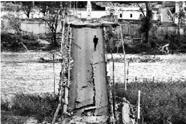
в) Зруйнований міст у Святогірську, Донецька область (03.10.2022)
