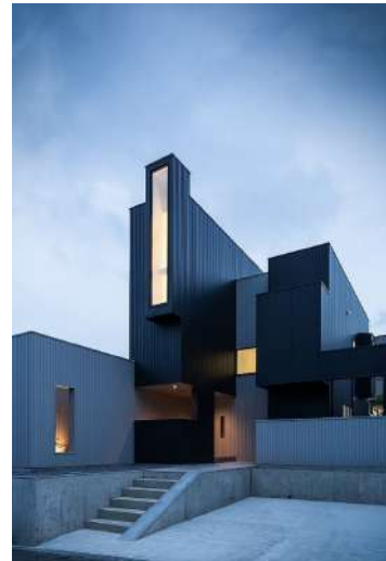
Рис. 17. Житловий будинок із складним силуетом
