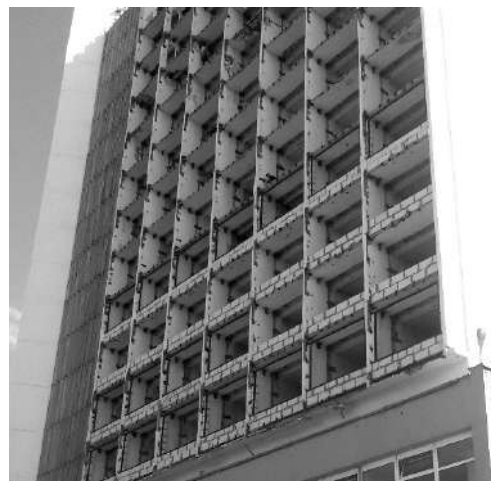
Рис. 13. Процес реконструкції. Зовнішня стіна. Приєднання лоджій до площі готельних номерів
