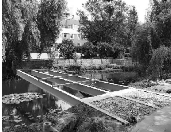
Рис. 15. Місток під час монтажу.
