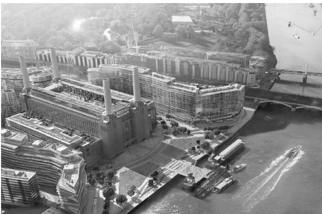
Реновація електростанції Battersea Power Station. м. Лондон. Великобританія
