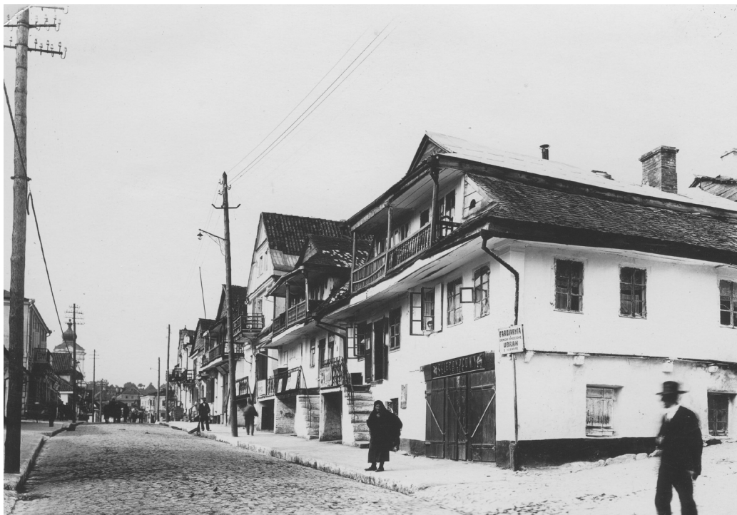
Рис. 1 – Вигляд на забудову історичного середмістя Кременця (вул. Широка).
