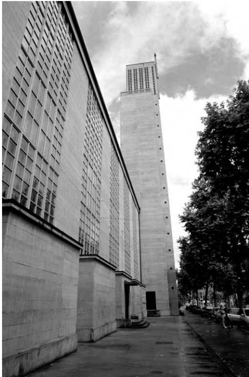
Рис. 1. Фасад вздовж вулиці
