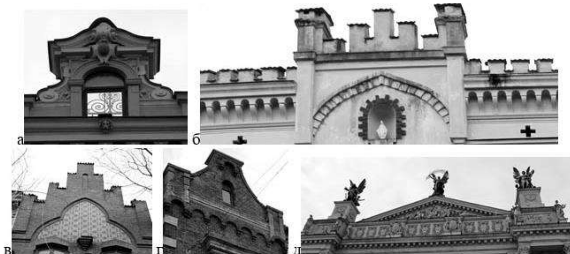
Рис. 5. Аттики та карнизи: а) аттик криволінійний із люкарною (пр. Свободи, 27); б) аттик зубчастий (вул. Каліча Гора, 7); в) аттик сходинчастий (вул. Листопадового Чину, 11); г) аттик комбінований (вул. Ген. Чупринки, 61); д) розвинений антаблемент з фронтоном (пр. Свободи, 28).
