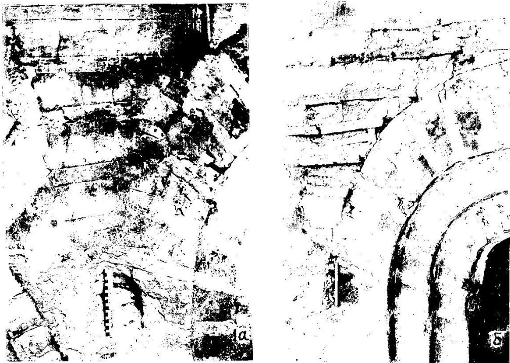
Рис. 2. Михайлівська церква Видубицького монастиря в Києві. Фрагмент мурування між арковими перемичками порталу і південного вікна на західному фасаді: а – вигляд до ремонту, б – під час ремонту.
