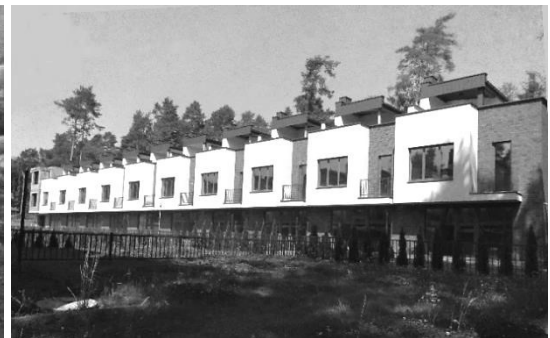
Рис. 5. Брюховичі, забудова новопосталої у лісовому масиві вул. Івана Труша, 2020 (фото Петришин Г.)
