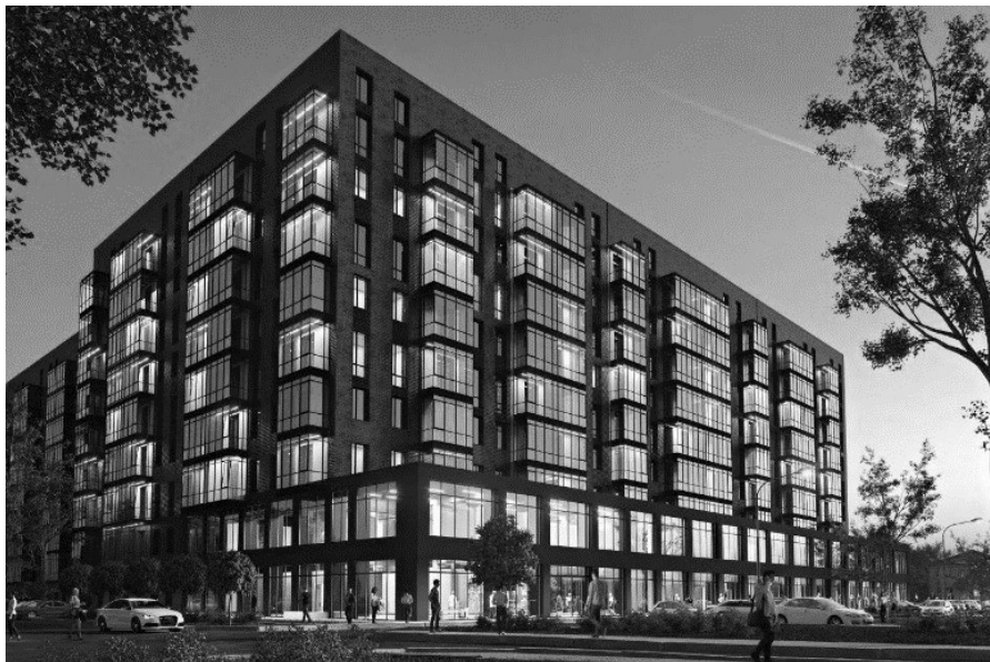
Рис. 8. Загальний вигляд житлового будинку.
