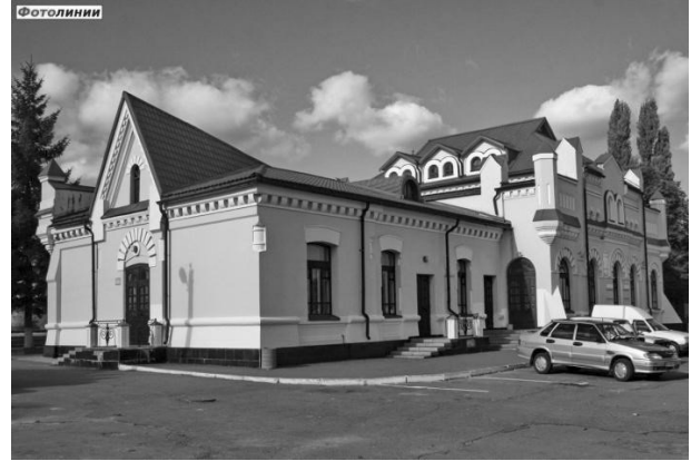
Рис. 14 – Залізничний вокзал станції Олевськ. Фото. Поч. ХХІ ст. [22]
