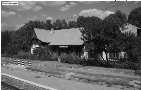
Рис. 17 – Залізничний вокзал станції Стремигород. Фото. Поч. XXI ст. [26]
