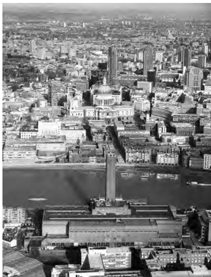
Рис. 9. Джейлз Гілберт Скотт, Банксайд, електростанція, 1947–1963, закрито у 1981 році, Лондон
